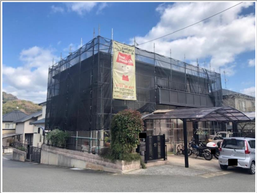
足場組立完了
